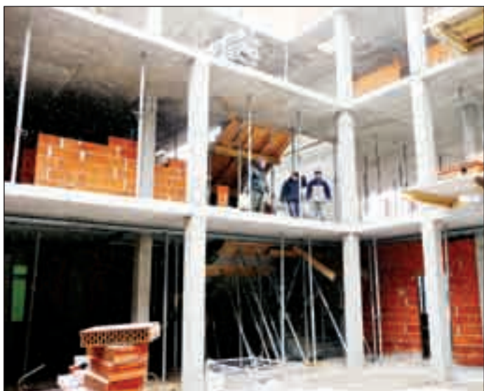
A tartószerkezet után már a falazatok készülnek
